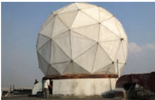
BMD既設ダッカ気象レーダー観測所外観(写真: JICA)
