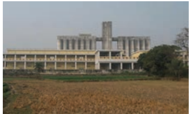
食糧備蓄能力強化計画(2012)によって建設された食糧倉庫全景 (写真: JICA)
