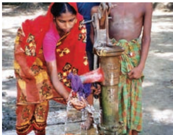
フィールドキットのテストで基準を超える砒素を含む管井戸を赤く塗った(写真: アジア砒素ネットワーク)
