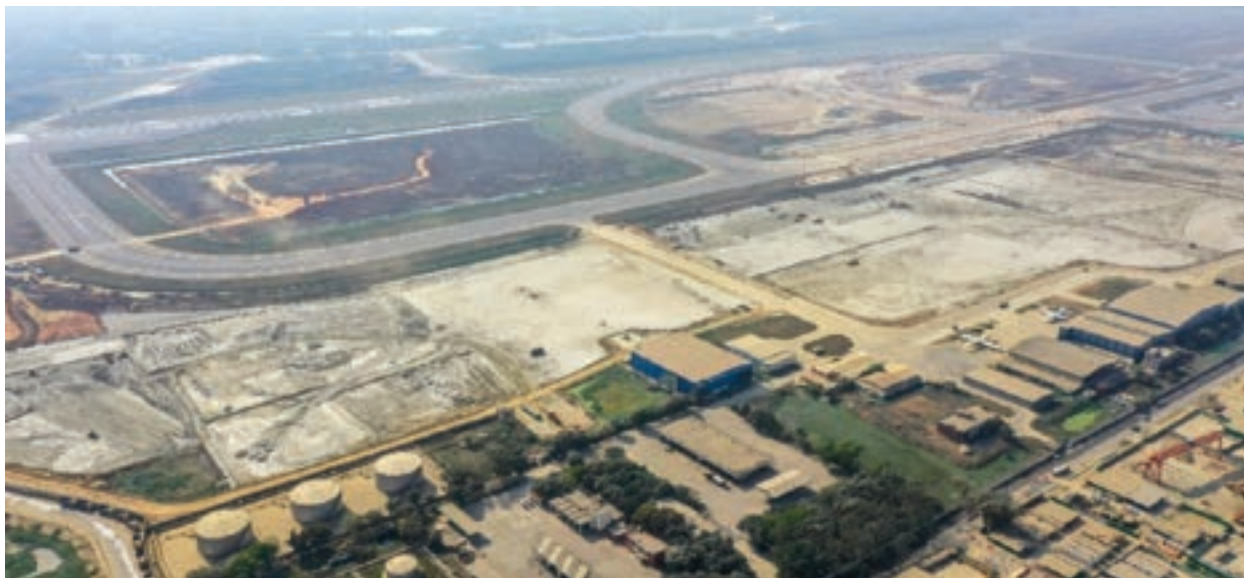
ダッカ空港第3ターミナル建設現場 (写真: JICA)
