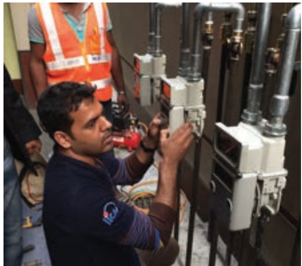
プライベートガスメーターの設置風景 (写真: ONODA株式会社)
