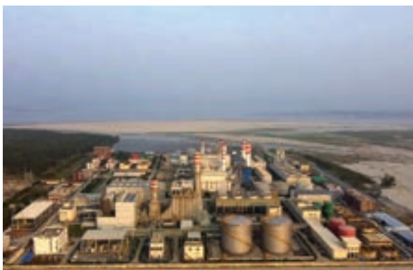
シラジガンジ高効率ガス火力発電事業 (写真: JICA)
