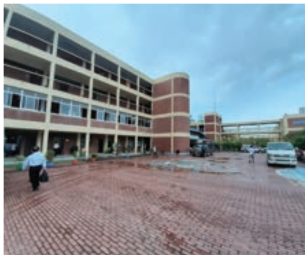
ボンゴボンドウ・シェイクムジブル・ラーマン農業大学事務棟 (写真: JICA)
