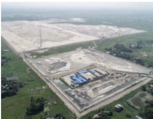
盛土の様子 (写真: 住友商事株式会社)
