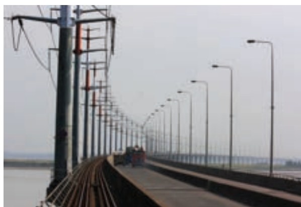
バングラデシュ国民悲願の「ジャムナ多目的橋」。一日に約11,000台の車両が通過するほか、列車の線路もある。送電線とガスパイプも併設されており、バングラデシュ東西をつなぐ大動脈となっている。(写真: Masud Al Mamun)
