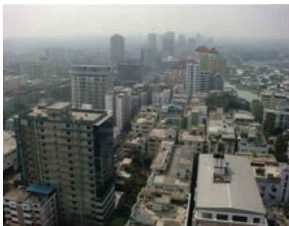
ダッカ市の様子: 耐震基準を満たしていない建物が多く存在する (写真: JICA)
