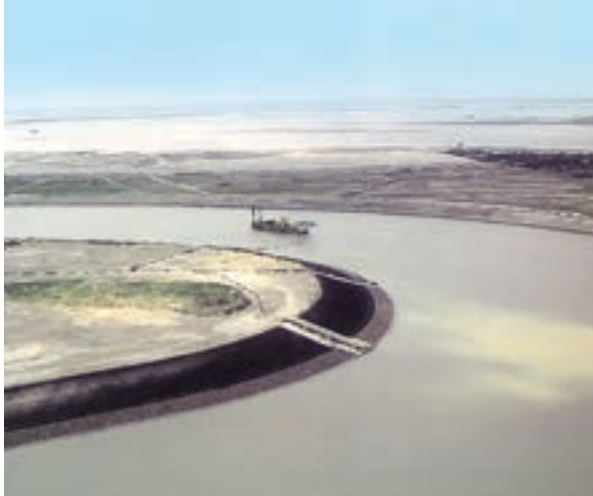
ジャムナ橋の西側ガイドバンド(護岸堤防) (写真: JICA)
