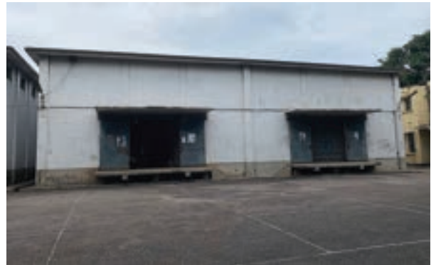
食糧倉庫建設計画(1970年代)によって建設された食糧倉庫外観 (写真: JICA)
