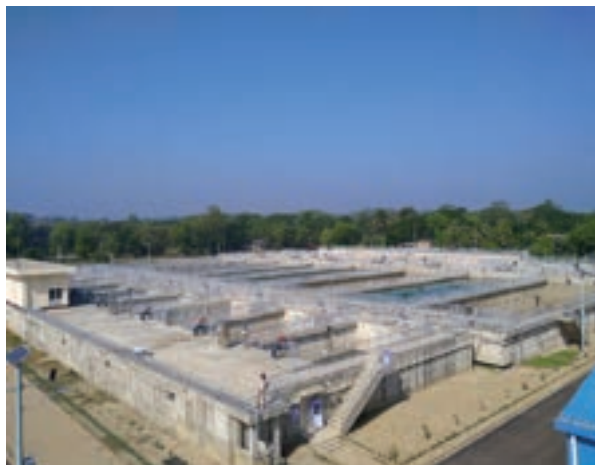
建設中のカルナフリ浄水場 (写真: JICA)
