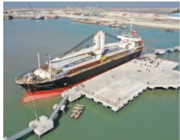
マタバリ港に停泊した大型船(写真: JICA)
