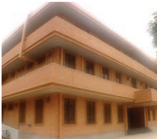
水質検査地方ラボラトリー外観 (写真: JICA)
