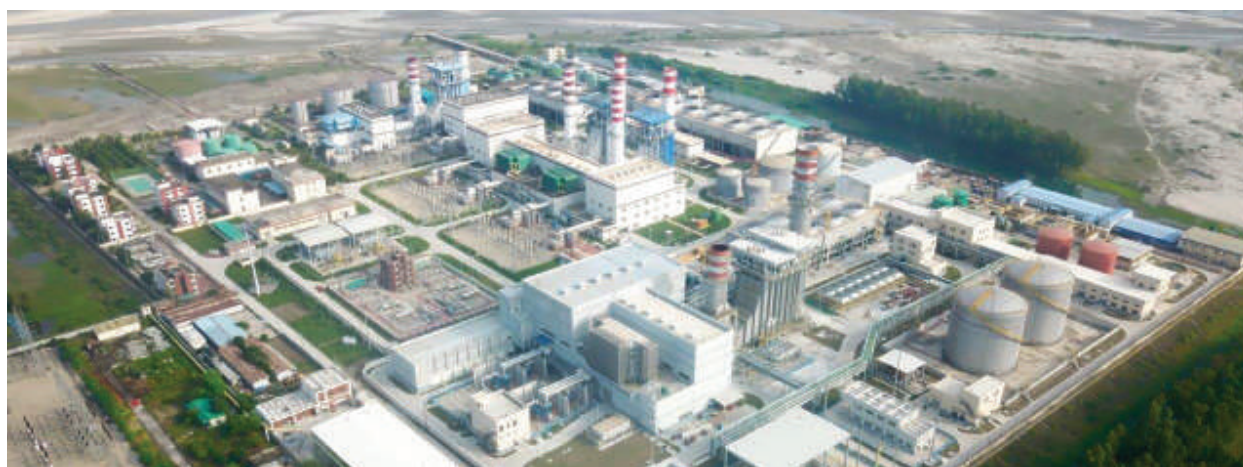
シラジガンジ高効率ガス火力発電事業 (写真: JICA)
