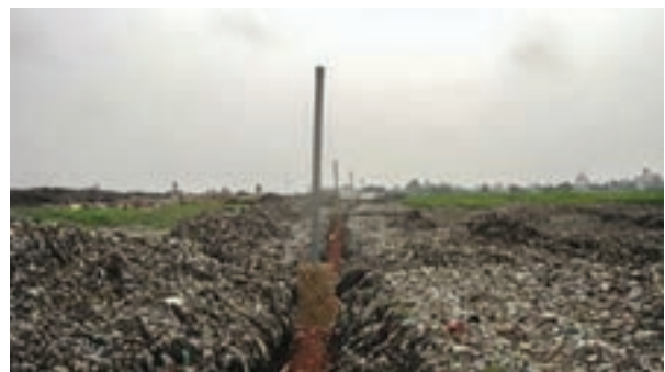
現在の処分場(ガス処理・覆土を行う衛生埋立て) (写真: 八千代エンジニアリング株式会社)
