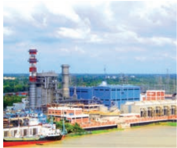
新ハリプール発電所 (写真: JICA)
