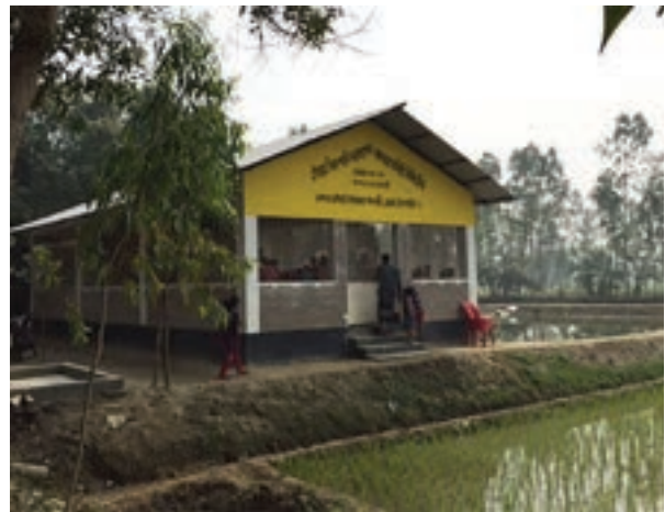
小規模水資源開発事業によって建設された水利組合オフィス (写真: JICA)
