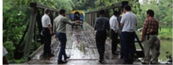
橋梁維持管理 現地調査の様子 (写真: JICA)
