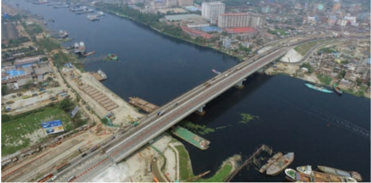
カチプール橋 (写真: JICA)
