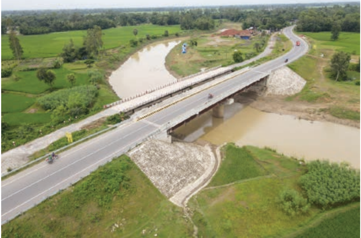
連結性強化関連で建設した橋 (写真: PW-02コントラクター)
