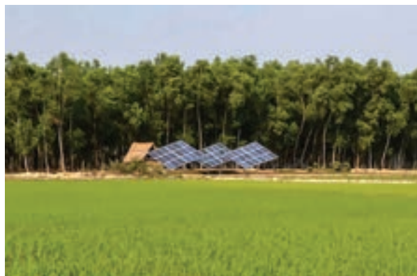
再生可能エネルギー開発事業は、円借款資金を現地金融機関を通じて企業や一般農民が利用するツーステップローン。この写真は主に灌漑ポンプに利用されている太陽光発電施設 (写真: JICA)
